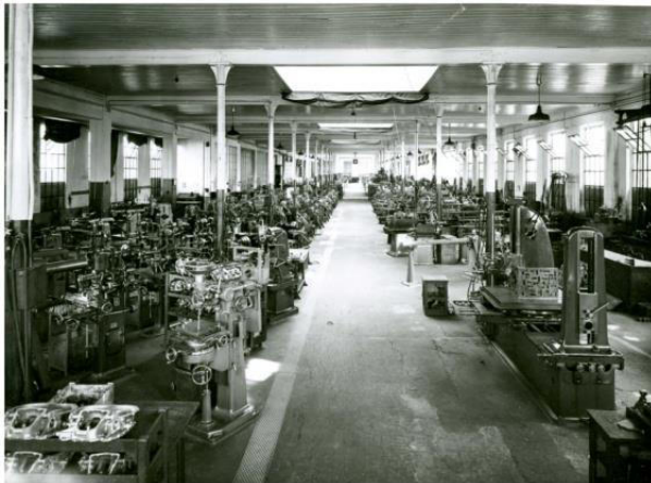
Neg.1995N Reparto macchine operatrici
