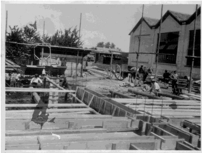
Neg.2238 Costruzione nuovo reparto macchine operatrici
