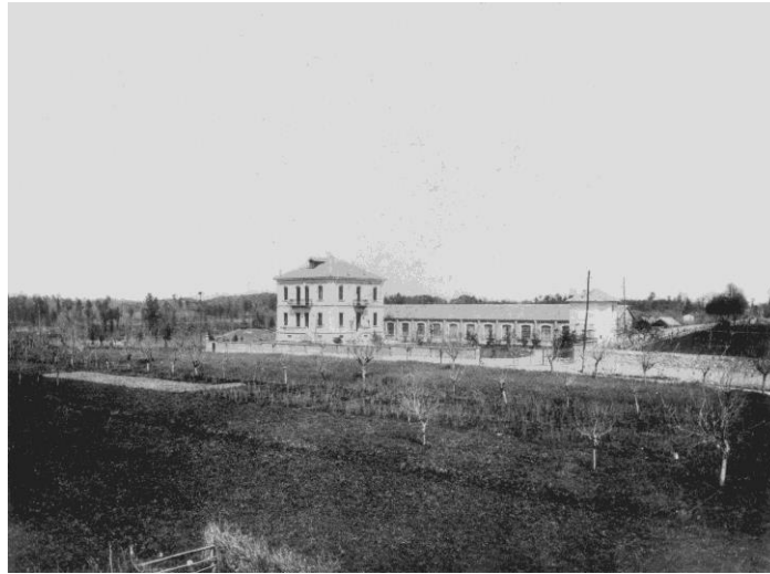
Neg.1015 Abitazione civile e capannoni con recinzione muraria.
