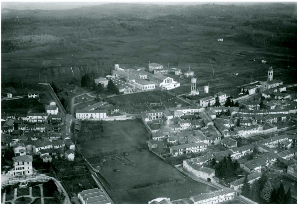
Neg.247 Vista aerea dello stabilimento nell'anno 1937
