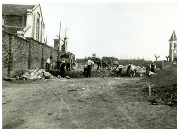
Neg.1532 Sistemazione del nuovo ingresso
