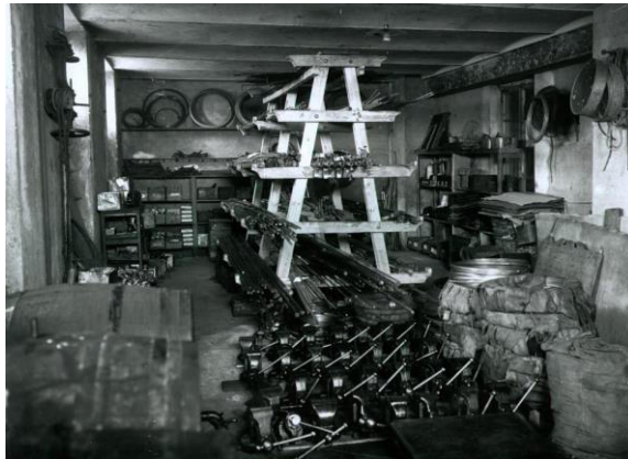
Neg.1863 Magazzino prodotti grezzi e vario per lavorazioni
